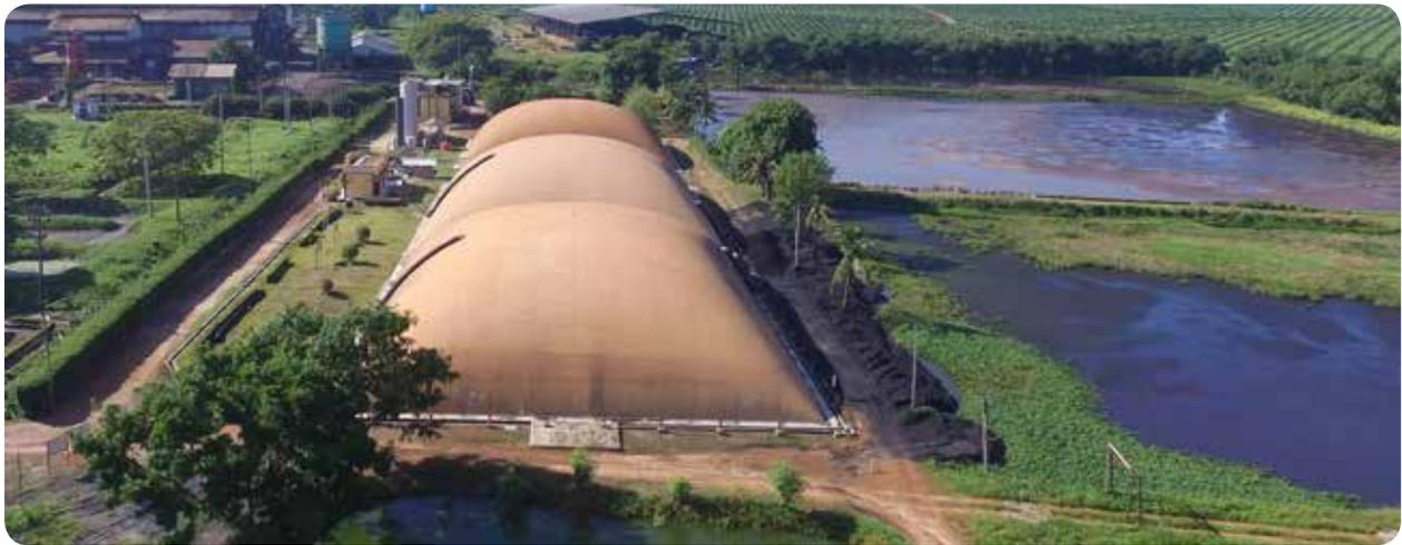
▲ Kolam limbah cair POME di pembangkit tenaga biogas AANE, yang memasok listrik ke jaringan lokal PLN di Belitung.
